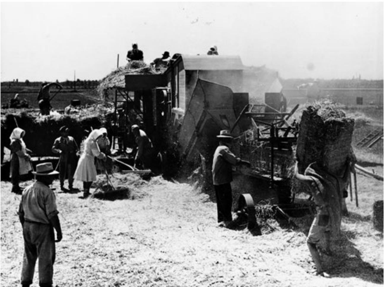
**Fig. 5L** - La trebbiatrice in azione simultanea con la pressa, che forma le balle di paglia. L'interesse maggiore dei contadini e dall'altra parte, dove i bocchettoni riempiono i sacchi di grano già pulito (idem).
