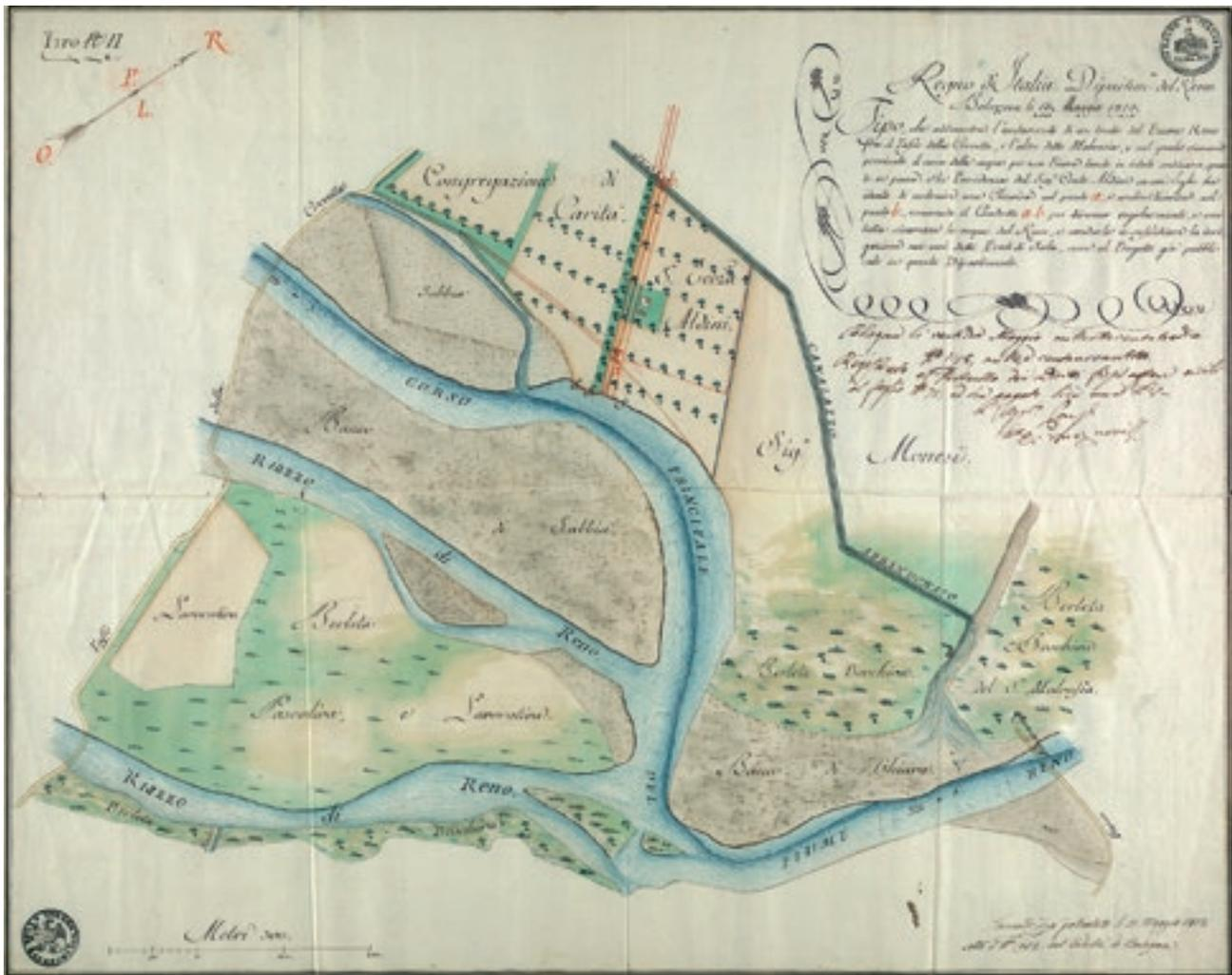
**Fig. 8 - Tipo del 16 maggio 1813 che illustra il tratto del Reno tra il Passo della Crocetta e l'altro detto Malvasia.** Chiavica a., Controchiavica b., invaso ab., costruite dal Conte Aldini per derivare con maggiore sicurezza le acque del fiume e irrigare le proprie risaie. Il corso del Reno forma in questo tratto grandi isole. (ACC. Prefettura, Tit. XXV, Rub. 3. 1813, b. 3).
