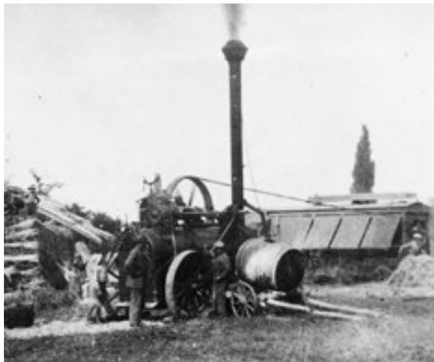
**Fig. 22** - Scavezzatrice meccanica azionata dalla macchina «locomobile» a vapore, in dialetto dette «la màchina e la gramadôura». (Archivio Famiglia Bassi - Tenuta Sacerno).
