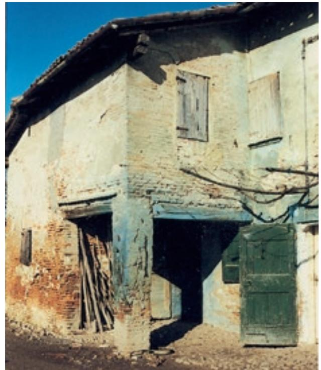
**Fig. 17** - Il portico, con le travi portanti in quercia.
