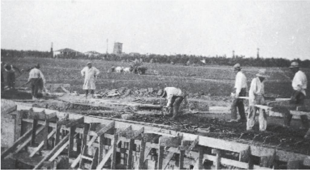
**Fig. 31** - Lavoro di posa di calcestruzzo nelle armature sul Ponte del Dosolo, nel 1931. Nello sfondo si vede la Torre del Gamberino e nella cavedagna un carro trainato da quattro buoi (ACC. Foto Storiche, busta nocciola, 1931).
